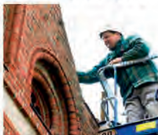
Ein Unternehmen aus Brunow (Landkreis Ludwigslust) übernahm die Reparaturarbeiten an der Kirche. Birgit Hamann
