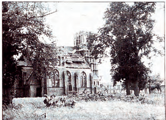
1984 wehte ein Sturm den Groß Lübener Kirchturm herunter.
